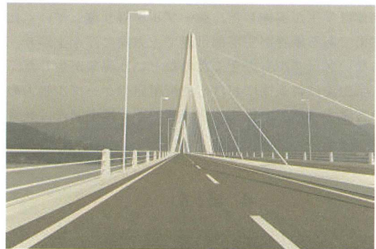
Fig.21 3 鋼管橋合成写真(近景)
