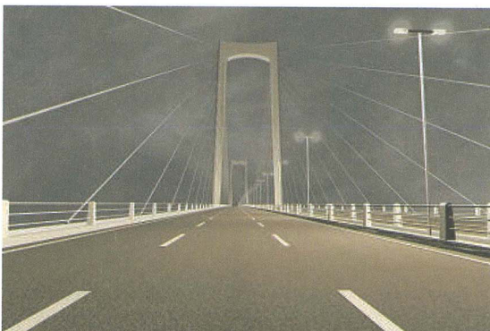
Fig.24 2 鋼管橋ライトアップ(路上)
