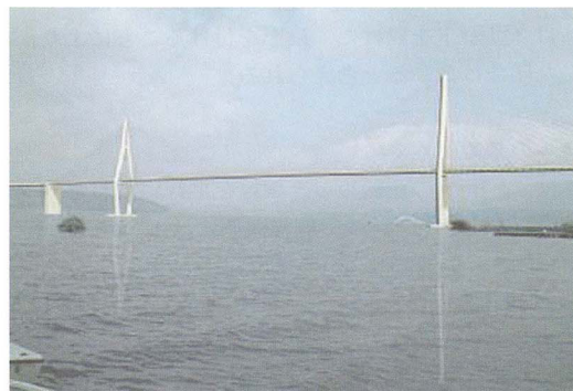
Fig.19 3 鋼管形式合成写真 (Fig.11 の B 方向から見た)
