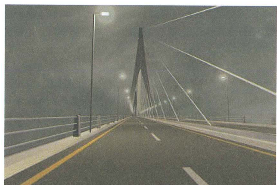
Fig.25 3 鋼管橋ライトアップ(路上)
