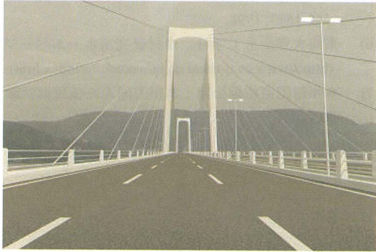
Fig.20 2 鋼管橋合成写真(近景)
